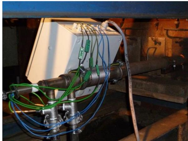
Abbildung 3–27: Eingebaute Korrosionsmesssonde am Dampferzeuger (Block A)
